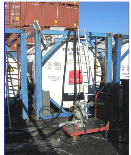
Beizen und Passivieren eines Tanks
