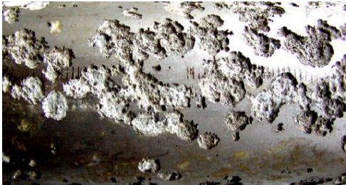
Kerbkorrosion an einer AISI 316 Leitung
