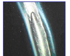
Inneninspektion einer Schweißnaht
