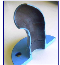
Die Ablagerung wurde entfernt und es wurde eine Phosphatschicht angebracht
