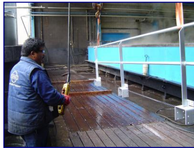
Sprühbeizen und Hochdruck abspritzen von Aluminiumgeländern
