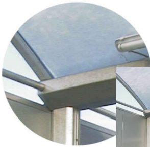
Anschlag auf Edelstahlteilen von Autowaschboxen
