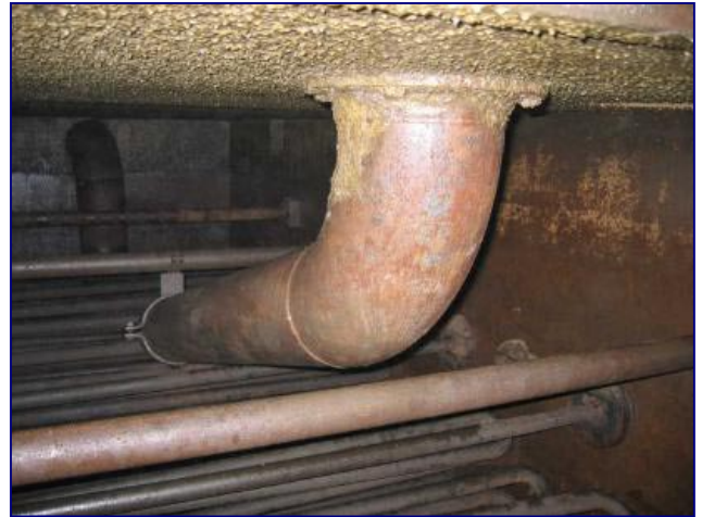
Foto 3: Tank vom Schmierölsystem ( 25\text{m}^3 ) nach dem Reinigen
